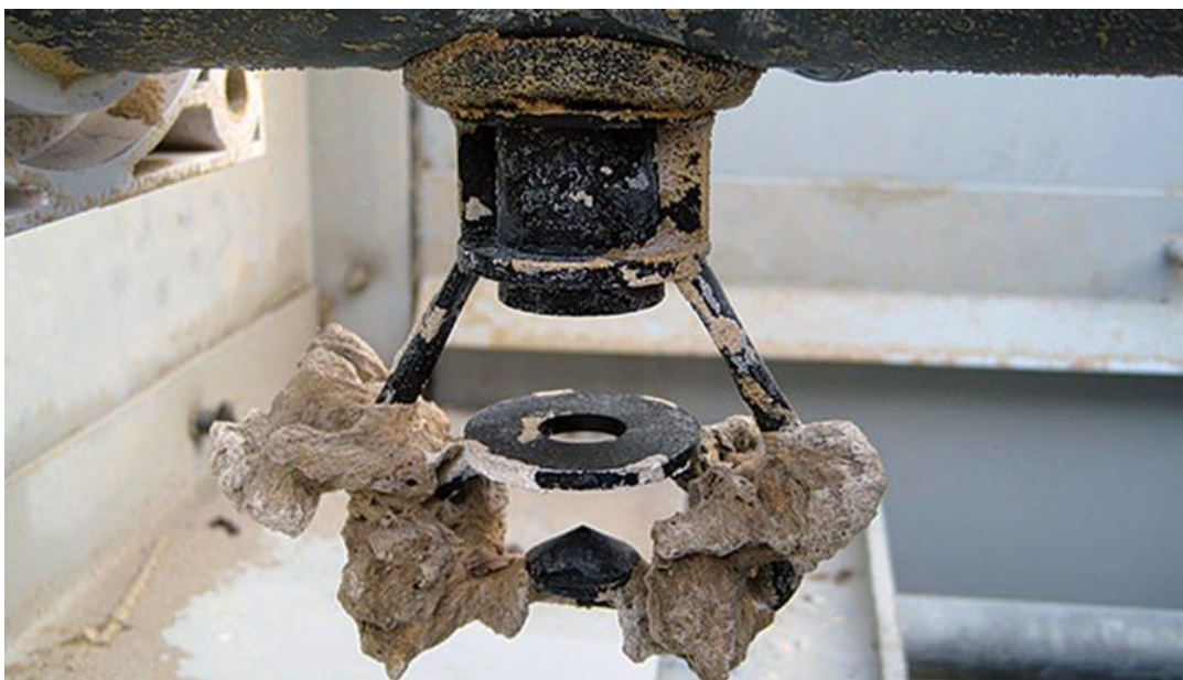
Slika 15. Nečistoće na mlaznici
