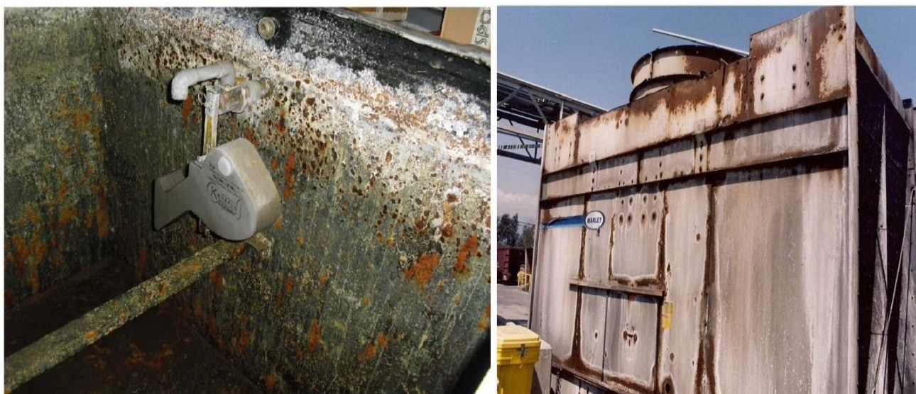
Slika 11. Problem korozije
