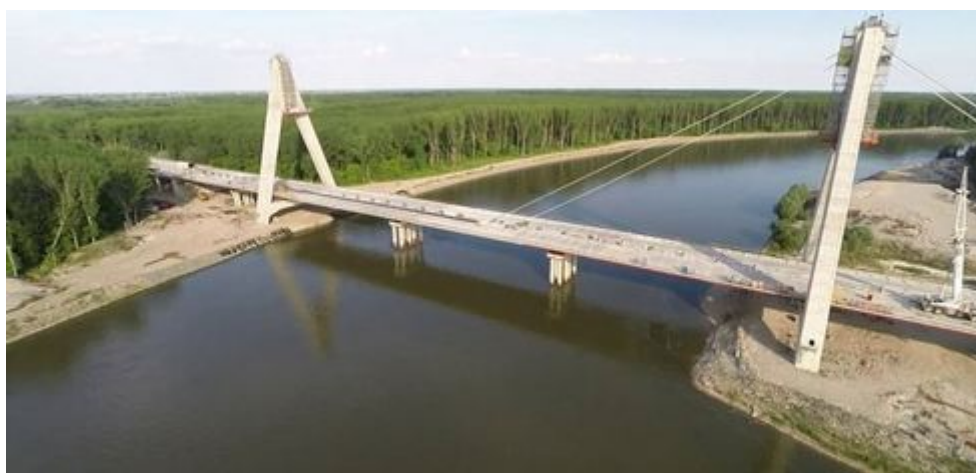
Slika 12: Most Drava u izgradnji [25]
