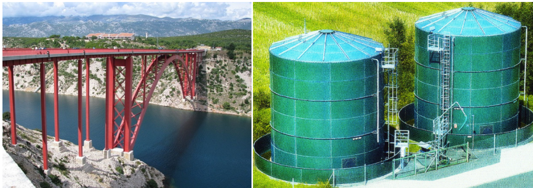
Slika 4: Primjeri klase izvedbe EXC4 [12,13]
