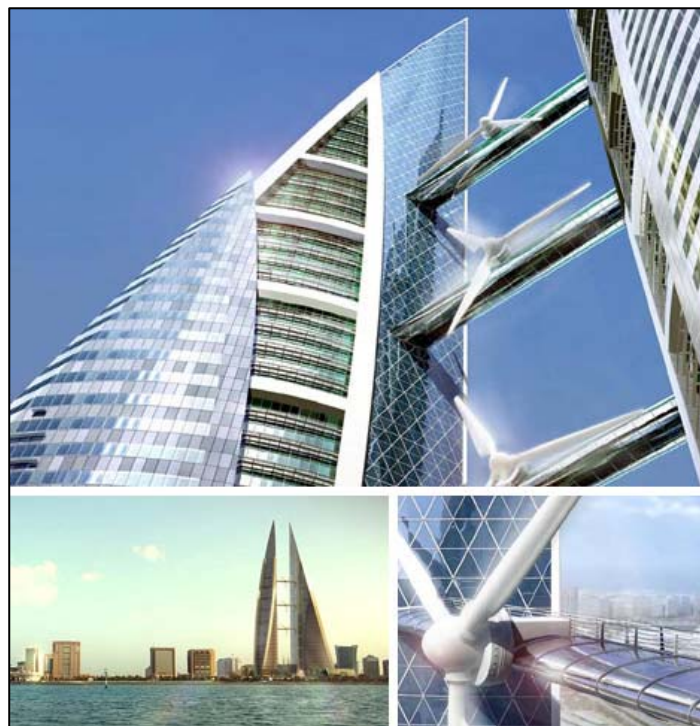
Slika 7.3. Prva građevina s instaliranim vjetroturbinama (3)
