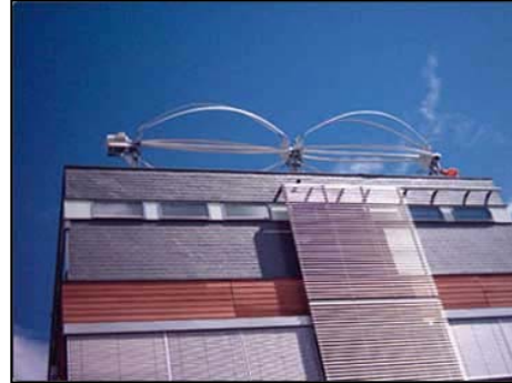
Slika 3.8. Horizontalne izvedbe Darrieusovih vjetroturbina
