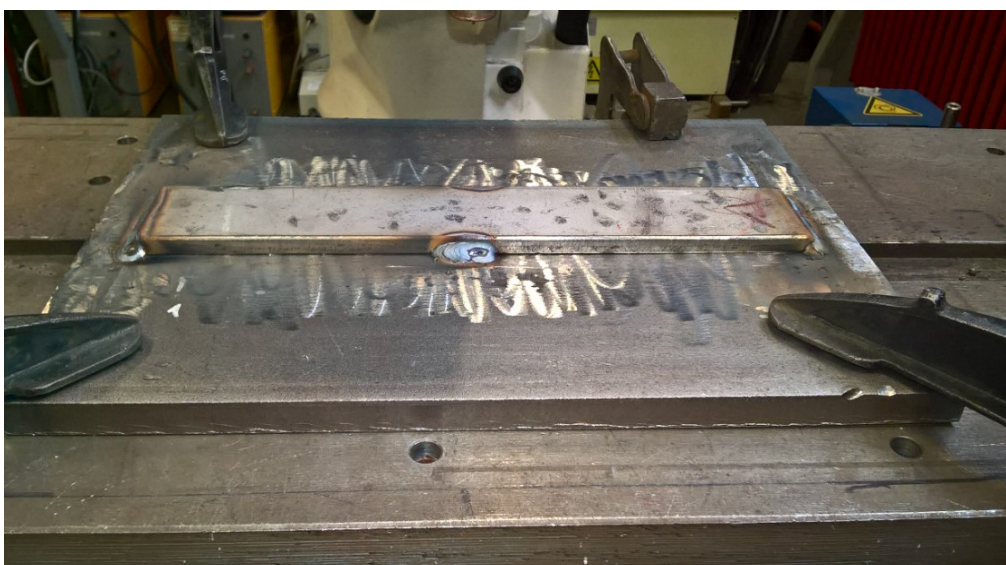
Slika 40. Pričvršćivanje ploče prije zavarivanja
