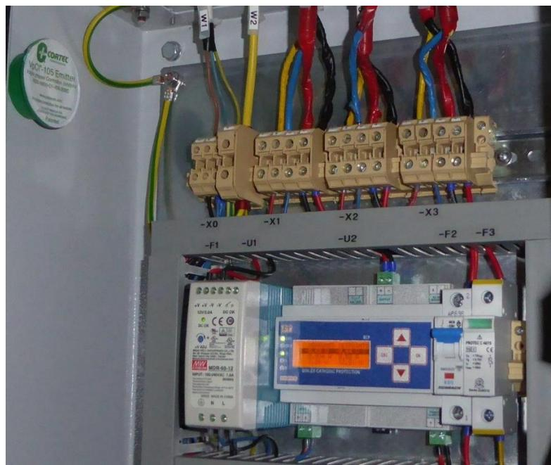
Slika 20. Zaštita upravljačkog ormarića sustavom katodne zaštite [18]
