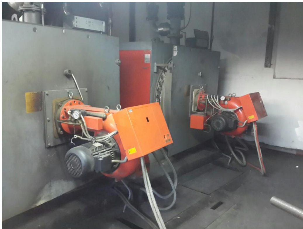
Slika 18. Prikaz zatvorenih kotlova u kotlovskom postrojenju
