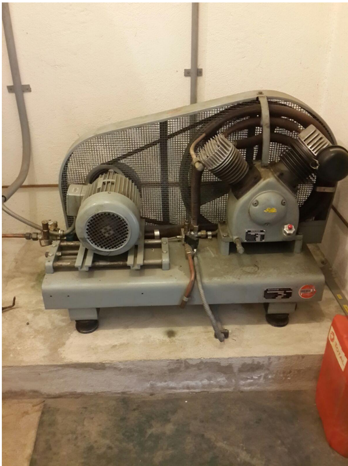
Slika 22. Kompresor za niskokomprimirani medicinski zrak (5 bar)
