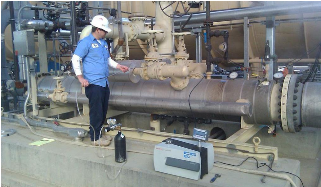
Slika 27: Ispitivanje istjecanja helijem [23]
