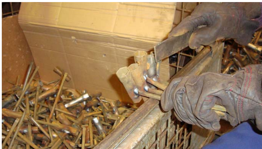
Sl. 28. Operacija čišćenja zavara
