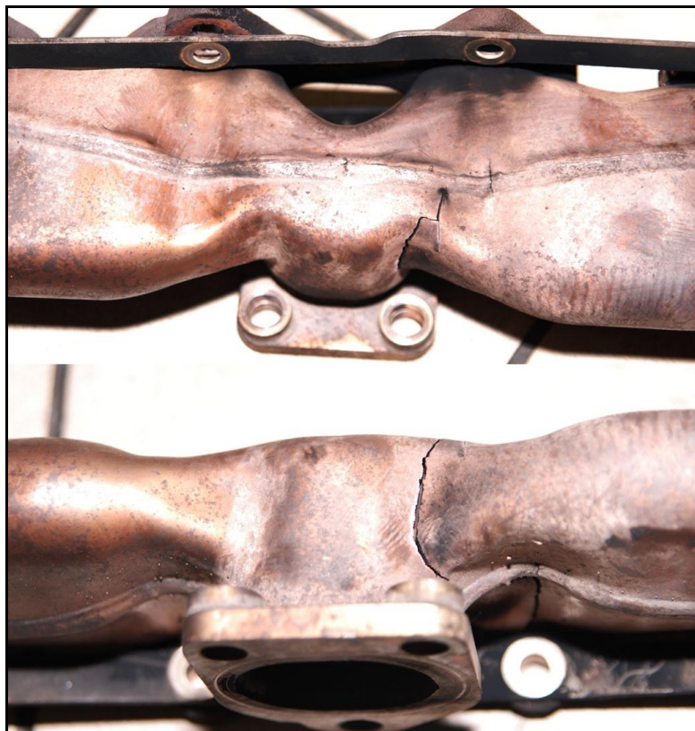
Slika 2.13 Pukotine na LSI ispušnoj grani serijskog BMW M57N motora [7]
