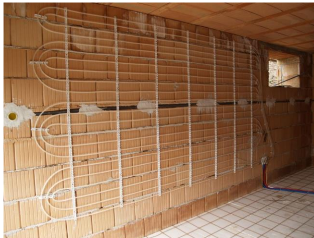
Slika 1.12. Zidne cijevne petlje
