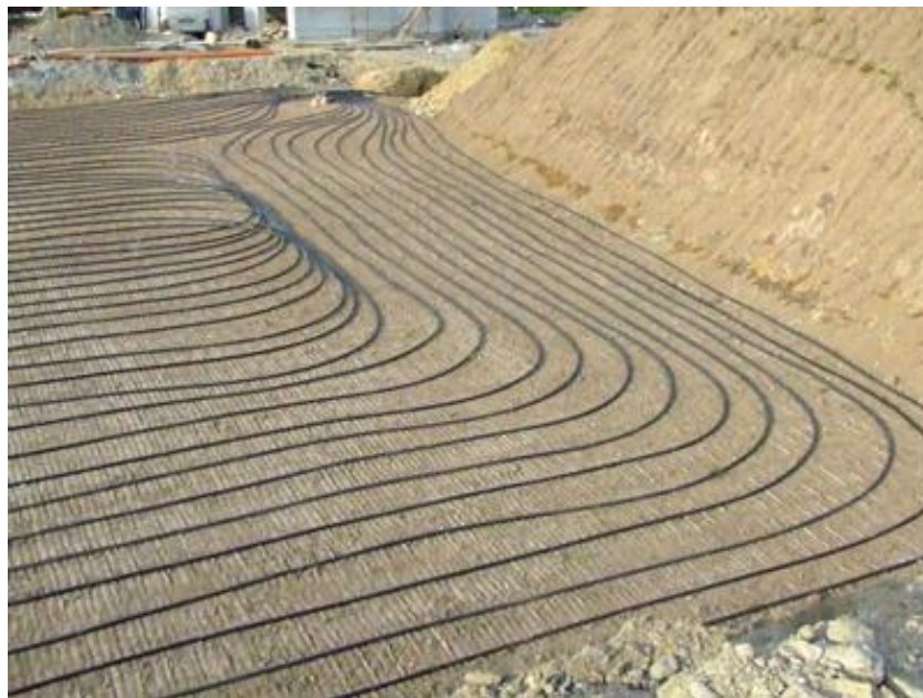
Slika 4.2. Primjer polaganja kolektorskog polja
