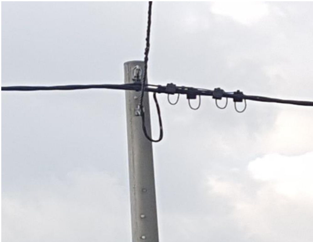
Slika 1. Izolirana odcjepna stezaljka na kablenskom snopu
