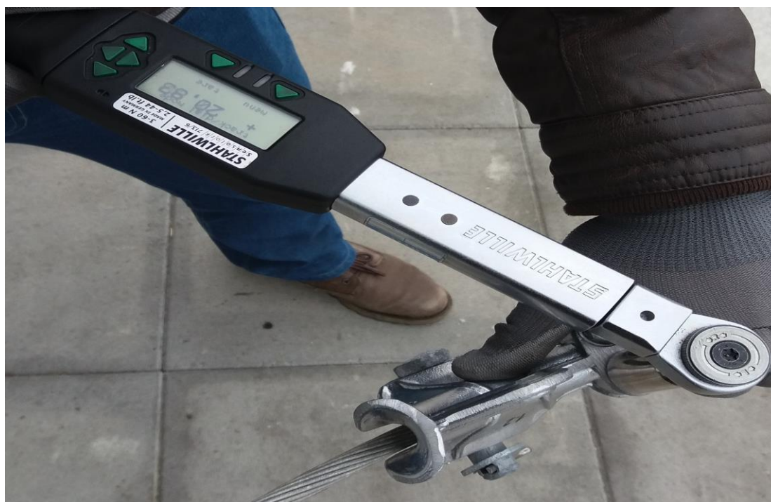
Slika 22. Pritezanje vijaka stezaljke s momentom 20 Nm
