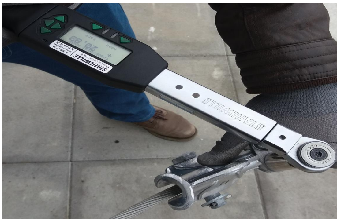
Slika 22. Pritezanje vijaka stezaljke s momentom 20 Nm
