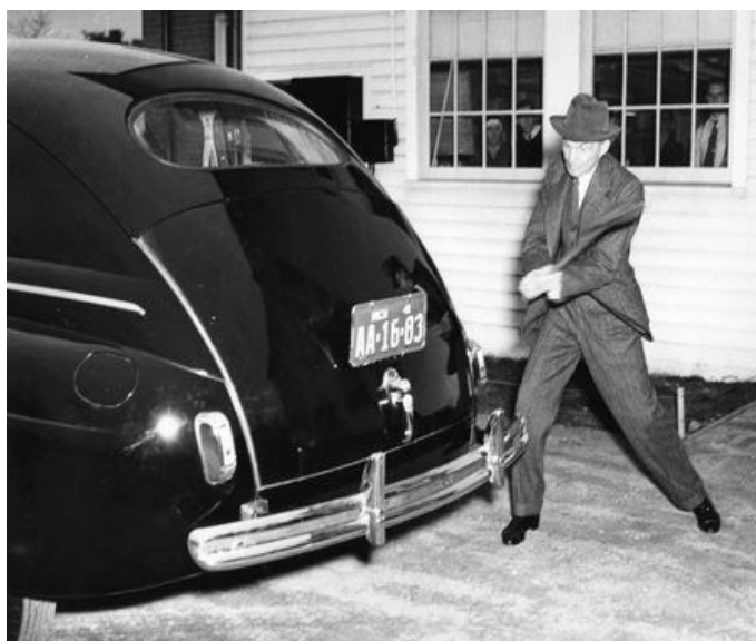
Slika 4.20. Prva karoserija od kompozita konoplje automobila Henry Forda [6]
