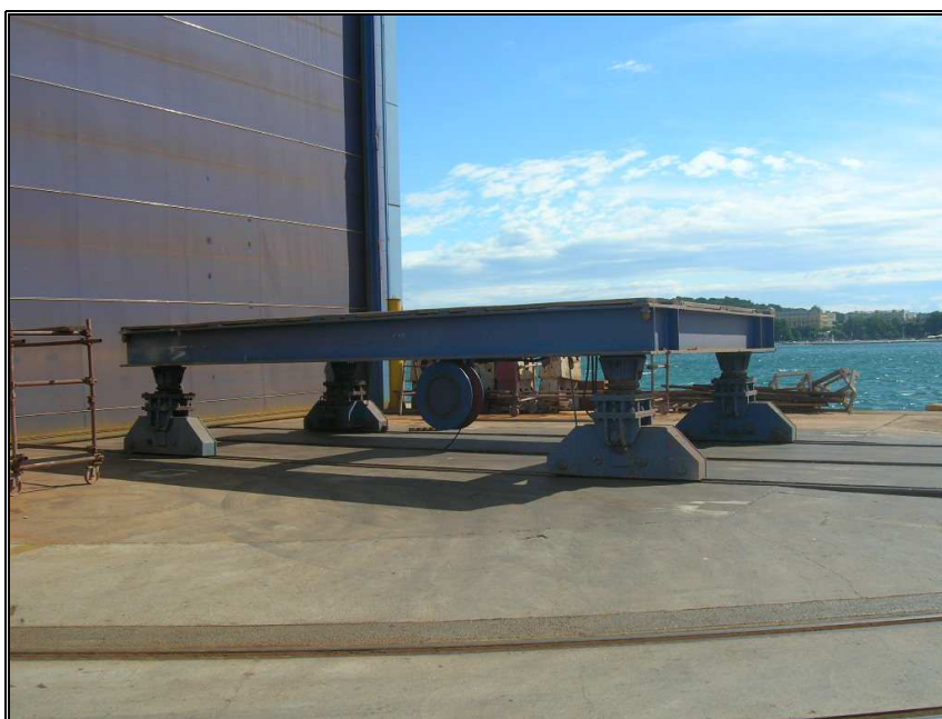
Slika 16. Tračni parterni transporter protočne radionice za antikoroziivnu zaštitu
