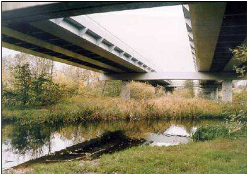
Slika 31. Dijelovi mosta zaštićeni vodorazrijedivim premaznim sistemom [14]
