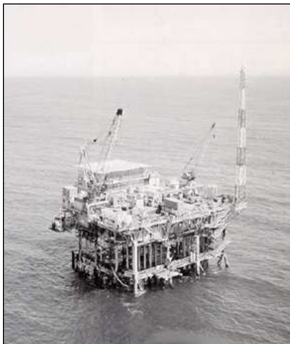
Slika 30. Platforma zaštićena vodorazrijedivim premazom [14]
