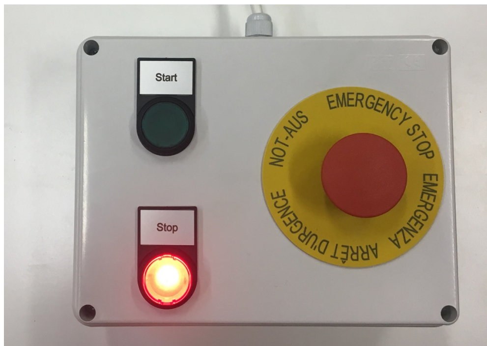
Slika 43. Signal isključenog napajanja ventilskog bloka
