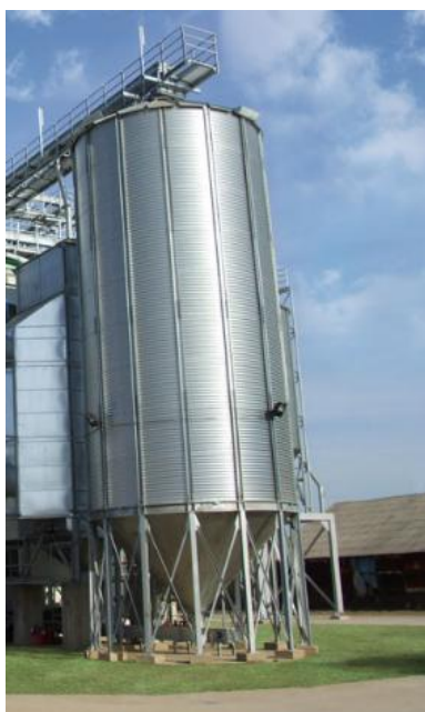
Slika 18. Silos s lijevkom
