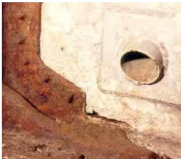
Slika 7. Kontaktna korozija aluminija u dodiru s čelikom [9]
