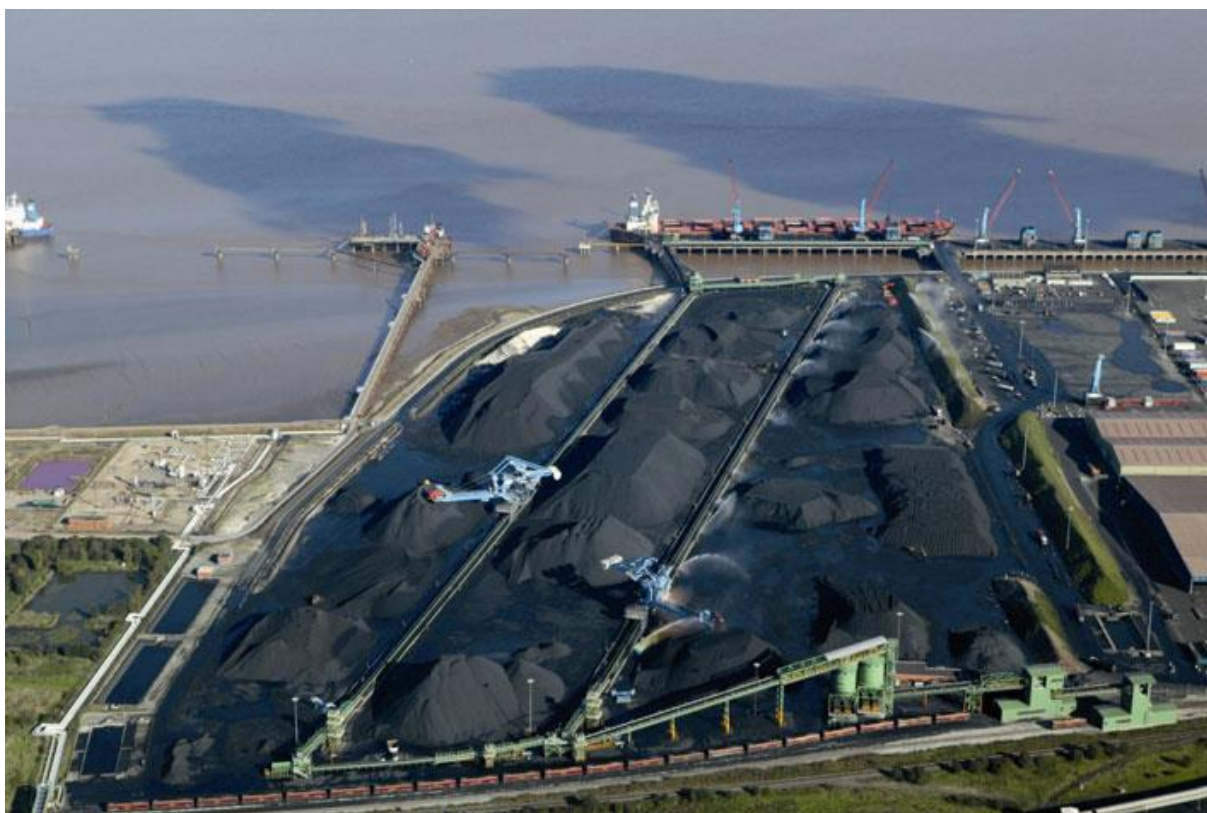
Slika 1. Odlagalište ugljena sa dva Stacker-Reclaimer-a
