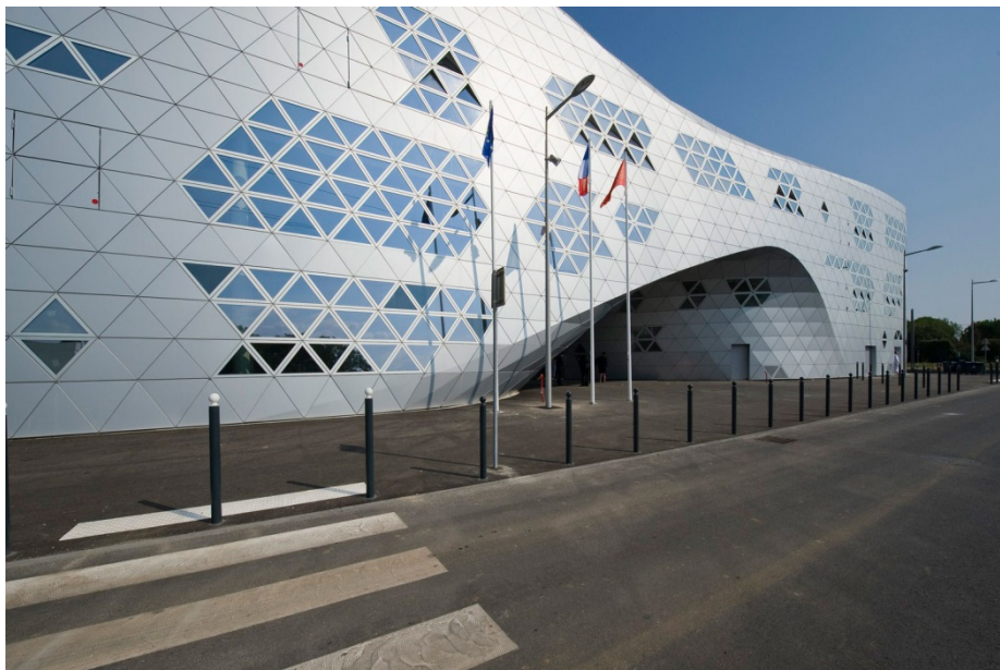
Slika 19. Pročelje zgrade od anodiziranog aluminija [35]
