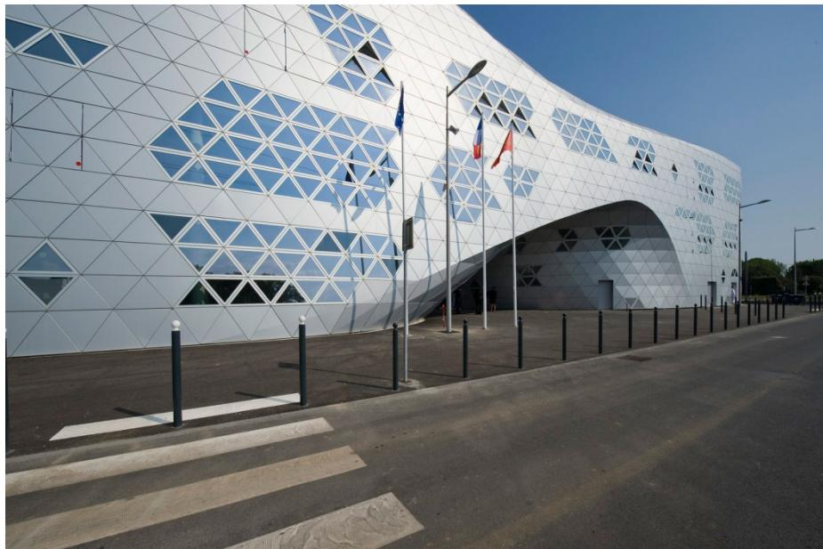
**Slika 19. Pročelje zgrade od anodiziranog aluminija [35]**
