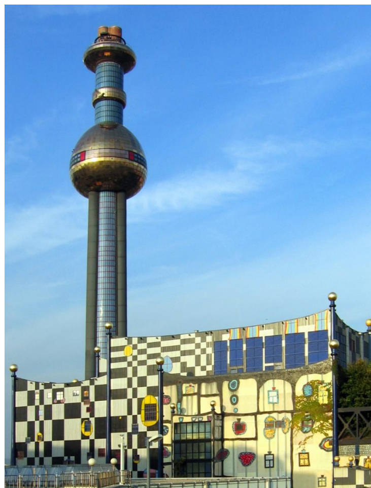
Slika 3.1. Spalionica otpada Spittelau (Beč, Austrija)[5]
