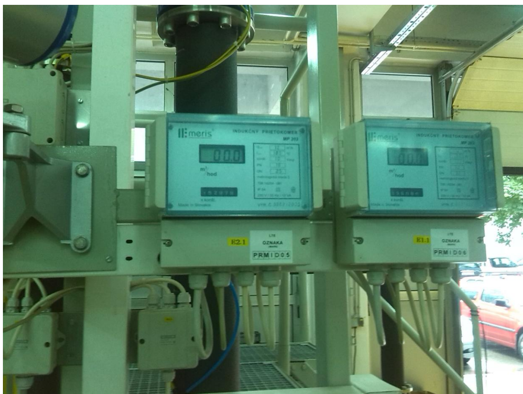
Slika 9. Dva magnetno - induktivna mjerila protoka mjerne linije G2T 90/50-100
