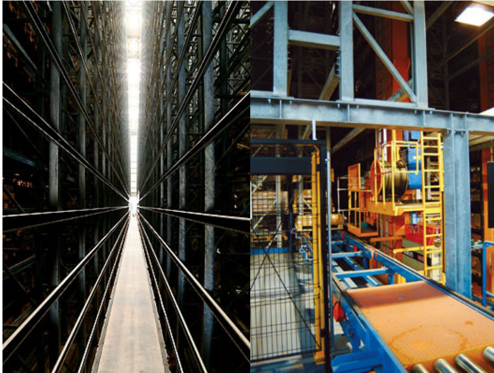
Slika 2.3. Primjer samonosećeg automatiziranog skladišta [7]
