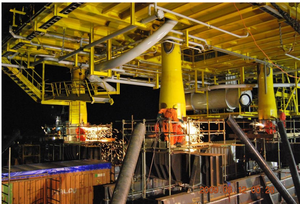
Slika 33. Uklanjanje morskog veza nadgrađa [15]
