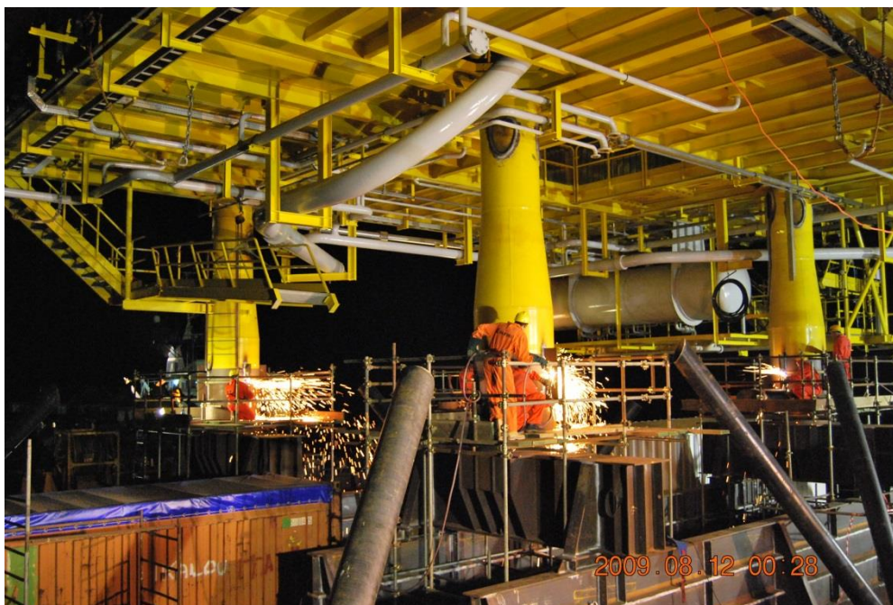
Slika 33. Uklanjanje morskog veza nadgrađa [15]
