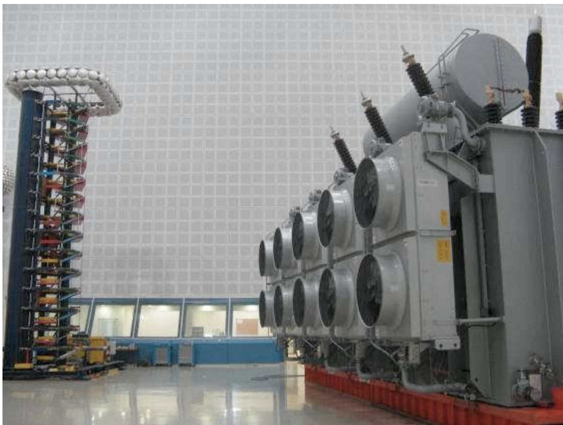
Slika 26. Prvo ispitivanje transformatora [28]
