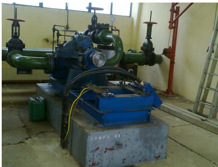
Slika 34. Prikaz postolja i pumpe prije postavljanja elektromotora
