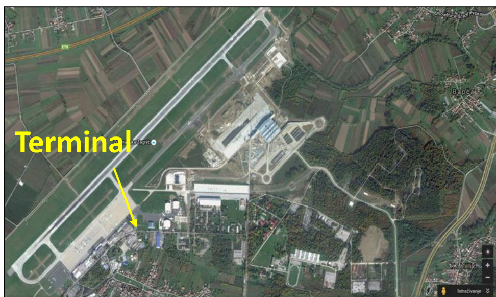
Slika 20. Terminal opskrbe zrakoplova Zagreb u sklopu prostora zračne luke Zagreb
