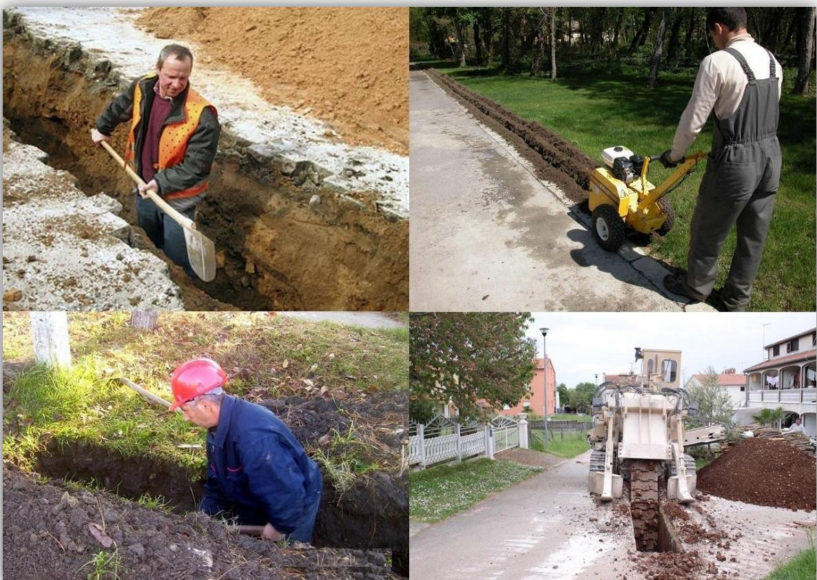
Slika 1. Primjeri pojednostavljenja radova iskopa korištenjem strojeva
