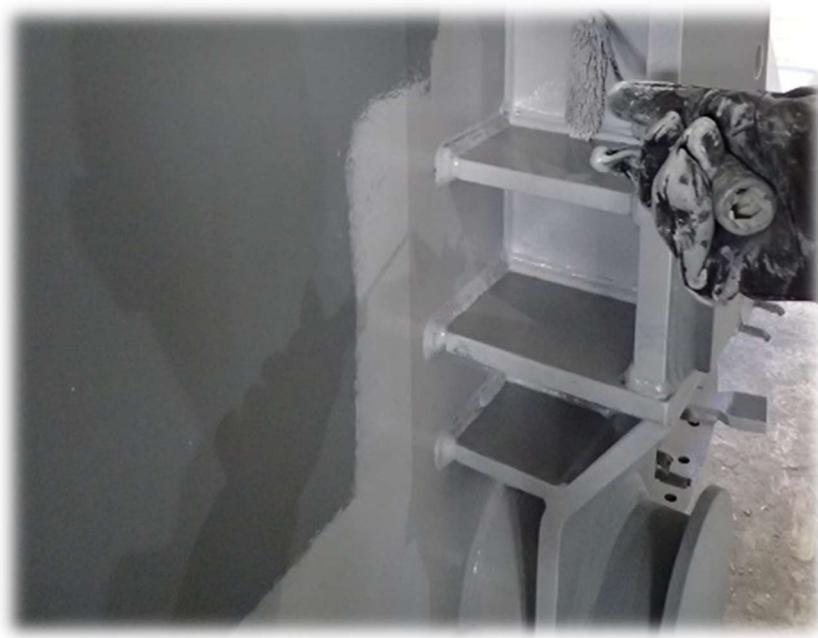
Slika 28. Epoksidni temeljni premaz i međupremaz [1]
