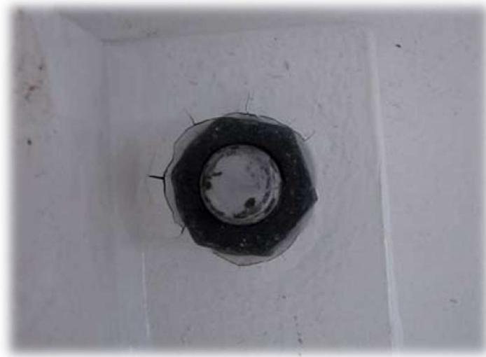
Slika 17. Pucanje premaza nakon zatezanja vijka [9]
