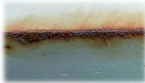
**Slika 33. Atmosferska korozija na oštem bridu [9]**
