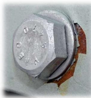
**Slika 34. Atmosferska korozija uslijed pucanja premaza [9]**
