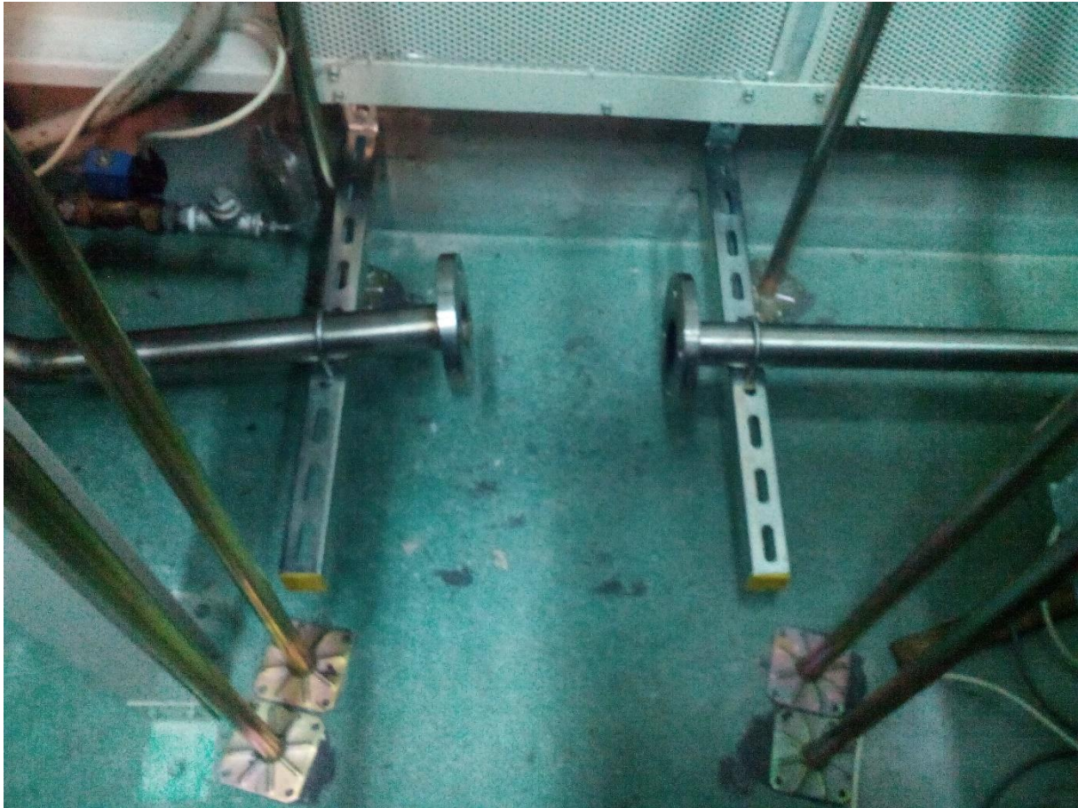
Slika 3.3. Mjesto na ispuhu za montažu ventila.
