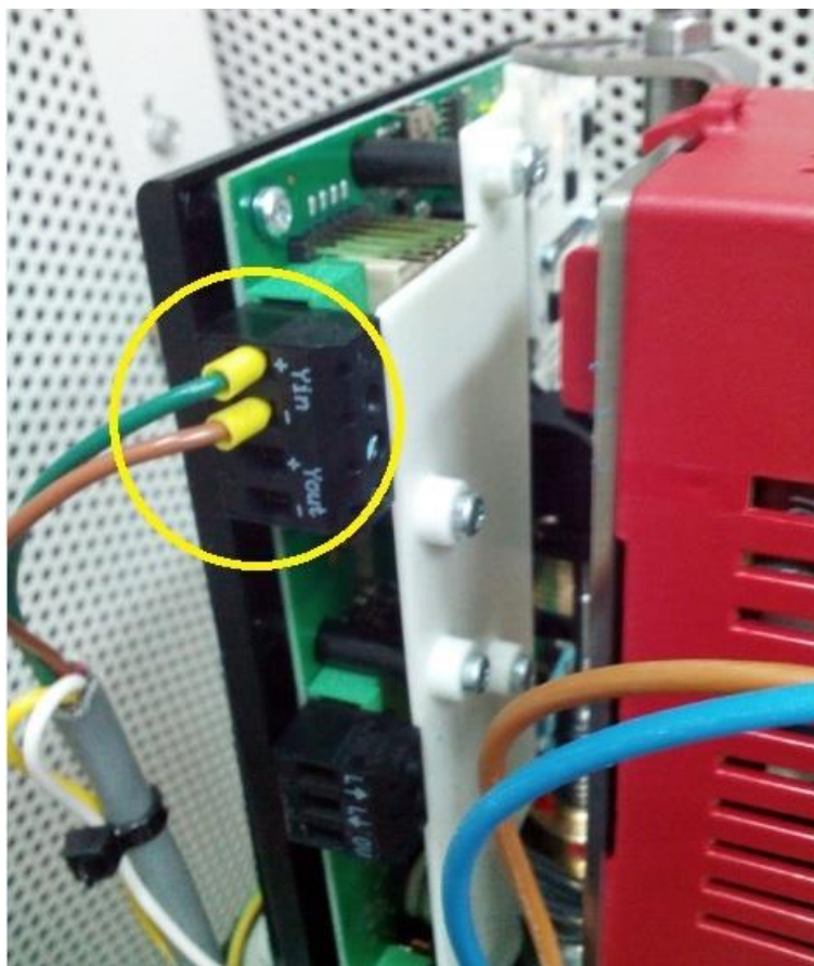
Slika 3.11. Spajanje signalnog kabla na aktuator.
