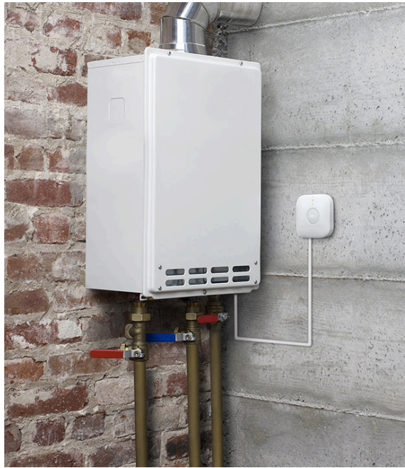
Slika 24. Nest predajnik spojen na bojler [17]
