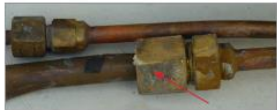
Slika 21 Uklanjanje mehaničkih spojeva cijevi lemljenjem [4]
