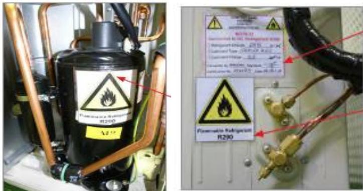
Slika 34 Označavanje vanjske jedinice [4]
