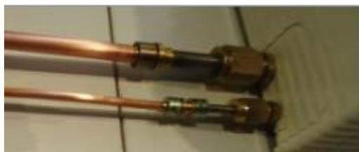
**Slika 23** Spajanje cijev s „Lok-ring“ spojnica [4]
