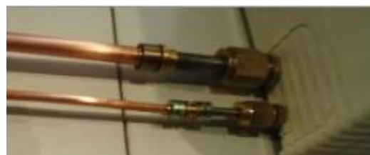
Slika 23 Spajanje cijev s „Lok-ring“ spojnica [4]
