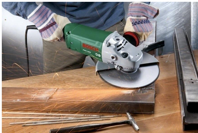
Slika 7. Brušenje zavarenog spoja [10]
