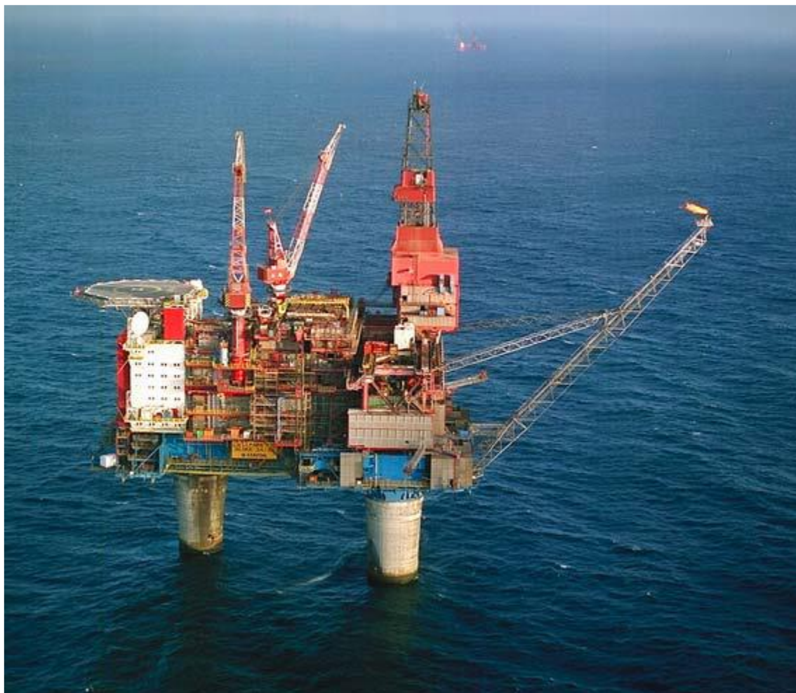
Slika 13. Platforma za vadenje nafte "Gullfaks B" [20]
