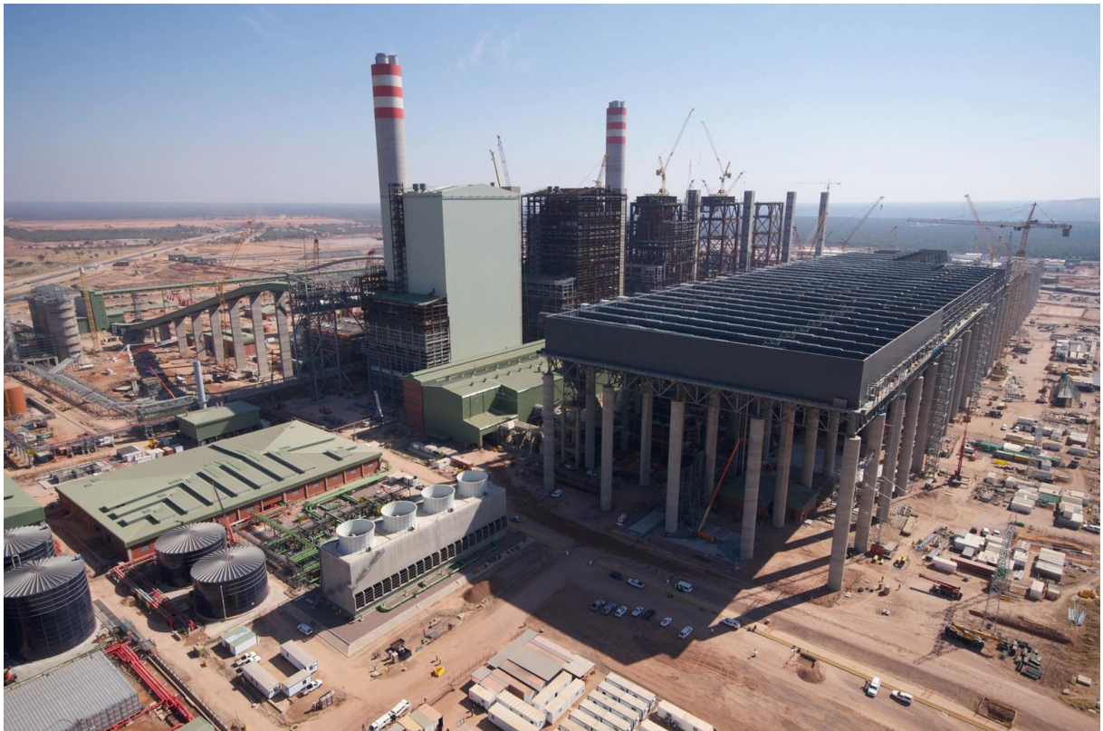
Slika 36. Gradilište elektrane Medupi [7]
