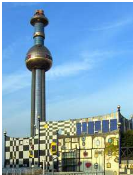
Slika 9. Spalionica otpada Spittelau (Beč, Austrija)
