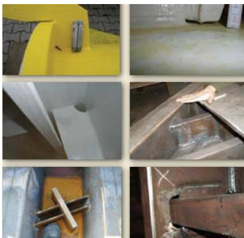
Slika 21. Prikaz površina koje treba izbjegavati prilikom nanošenja AKZ [2]
