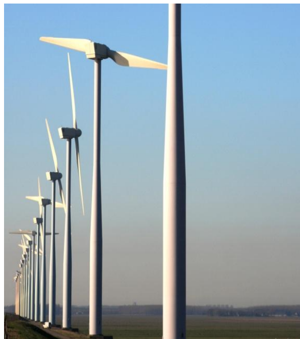
Slika 11. Rotor s dvije lopatice [10]
