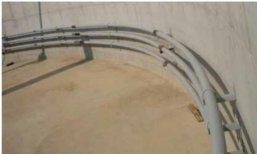
Slika 13. Cijevi za grijanje instalirane unutar fermentatora.
