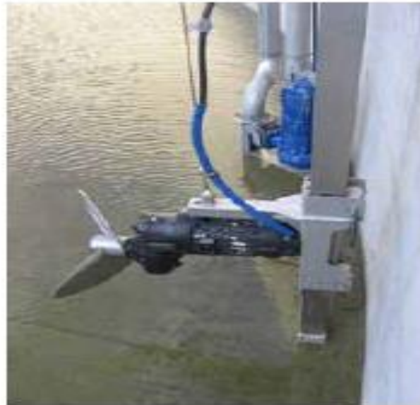
Slika 17. Motorna mehanička elisna mješalica sa mogućnosti potapljanja.
