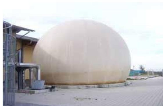
Slika 18. Vanjsko niskotlačno spremište za skladištenje plina.
