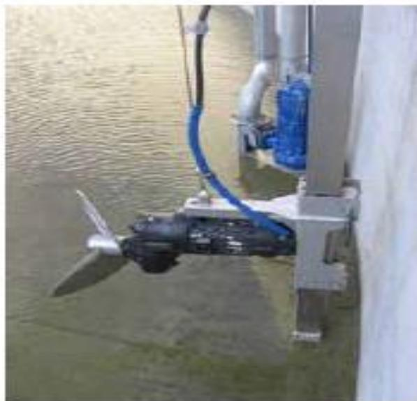
Slika 17. Motorna mehanička elisna mješalica sa mogućnosti potapljanja.
