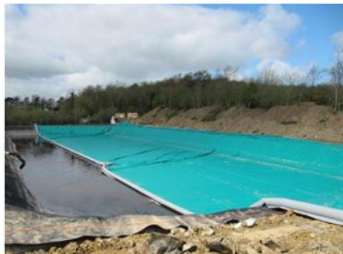
Slika 60. PVC pokrov spremnika digestata.
