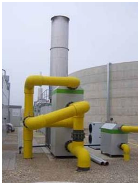
Slika 19. Moderna baklja za bioplin.
