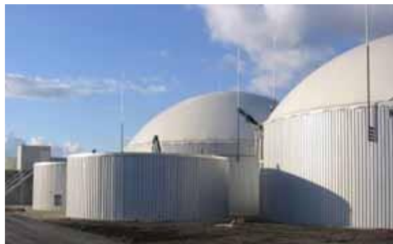
Slika 15. Vertikalni fermentatori pokriveni membranom koja ne propušta plin.
