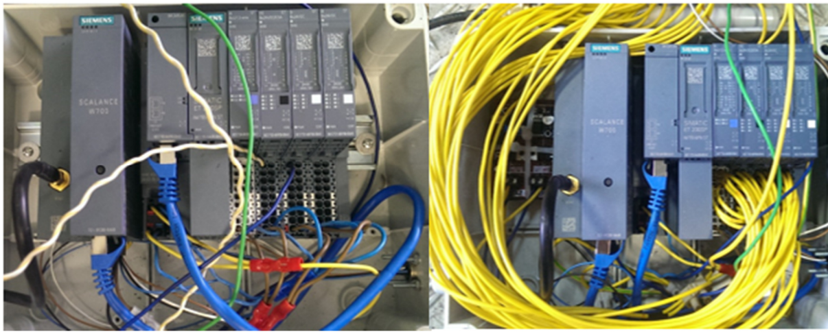
Slika 22. Distribuirana periferija prije i nakon spajanja elektroničkih komponenti
