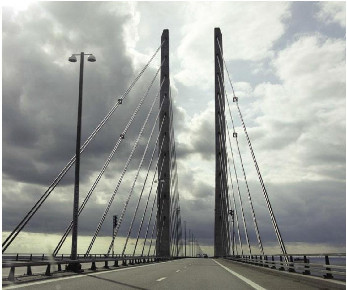
**Slika 37. Most Øresund zaštićen temeljnim premazom s visokim udjelom cinka, čiji sustav je projektiran tako da nema potrebe za naknadnim održavanjem više od 100 godina [28]**
