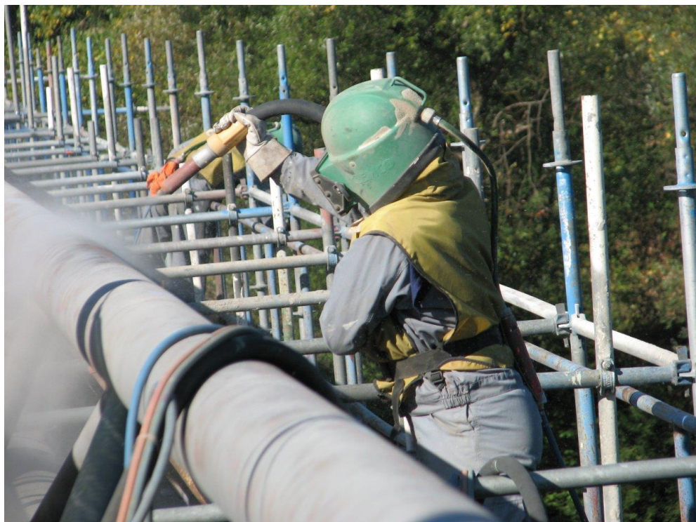
Slika 13. Prikaz pripreme površine postupkom pjeskarenja
