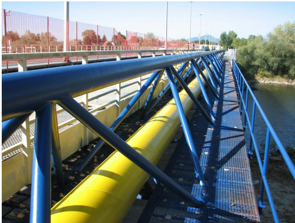
Slika 28. Primjena epoksidnog premaza na mostovima, Podsusedski most
