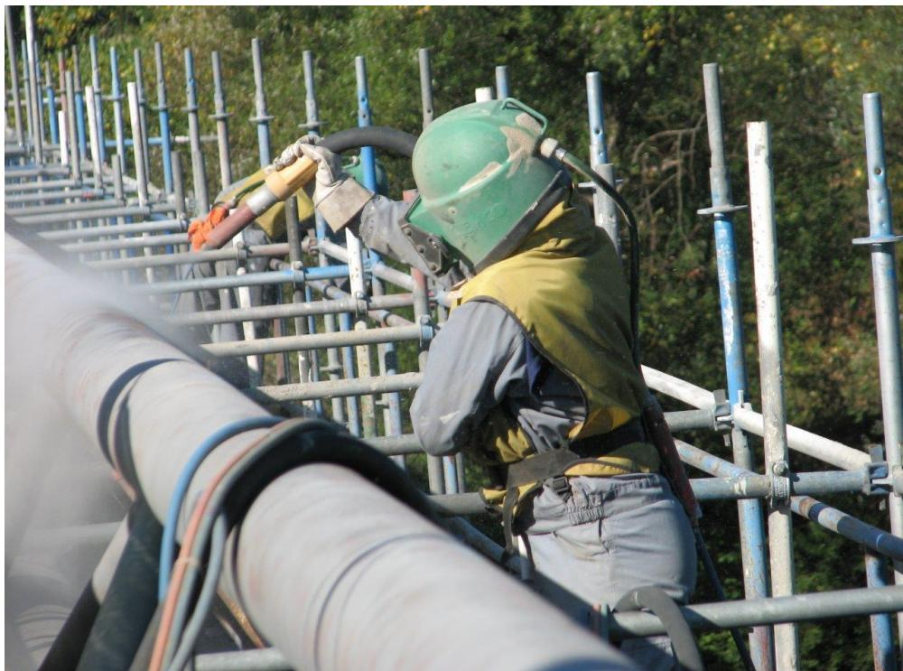
Slika 13. Prikaz pripreme površine postupkom pjeskarenja
