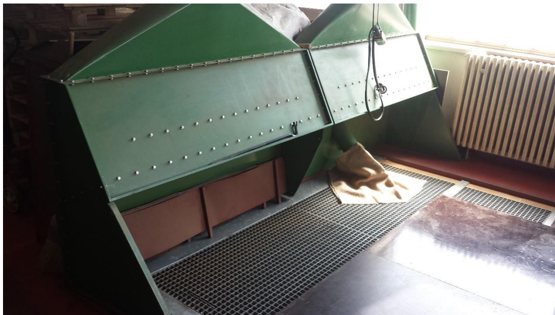
Slika 1. Usisna hauba na mjestu istovara sirove kave (1000kg)
