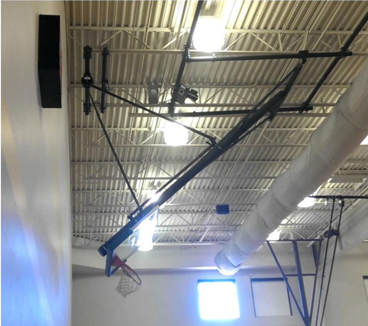
Slika 6. Konstrukcija s podizanjem unazad i pomakom prema naprijed u procesu podizanja
