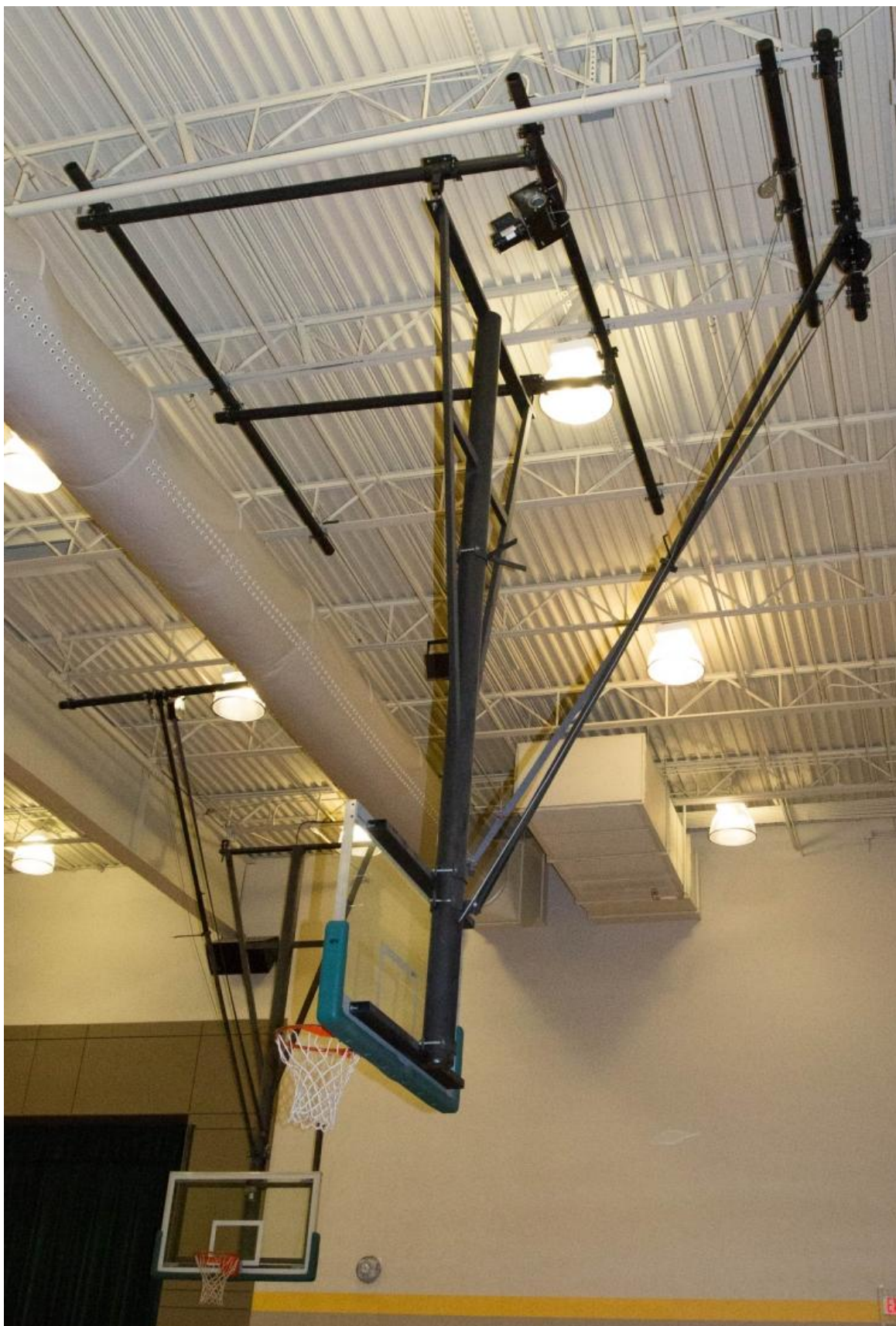
Slika 5. Konstrukcija s podizanjem unazad i istovremenim pomakom prema naprijed
