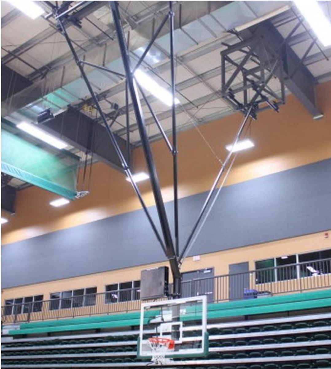
Slika 3. Konstrukcija s podizanjem unazad i polugom za učvršćenje sa stražnje strane
