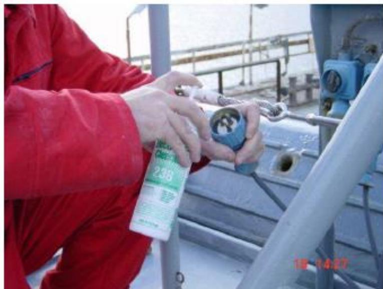
**Slika 13. Primjena inhibitora za zaštitu električnih kontakata [12]**
