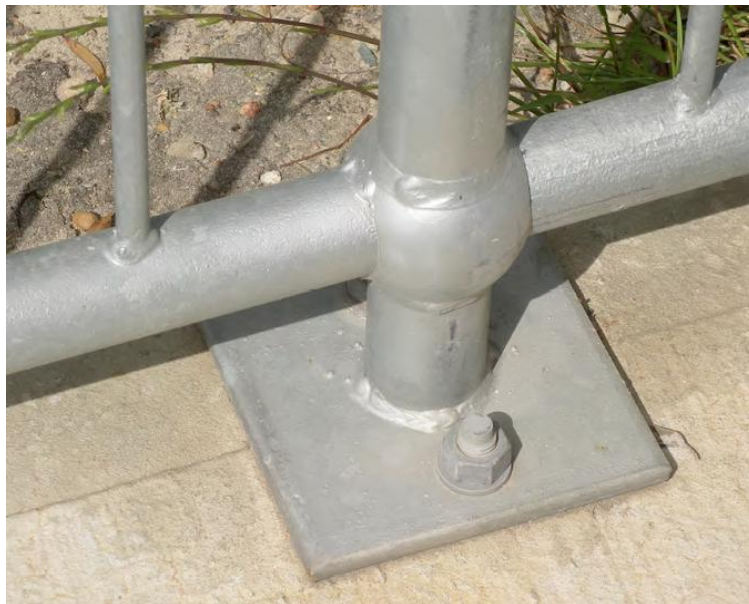
Slika 12. Primjer zavora na pocinčanoj ogradi [11]
