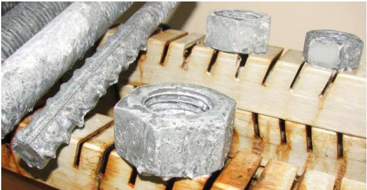
Slika 6.20. Bijela korozija cinka na vruće cinčanim uzorcima [22]
