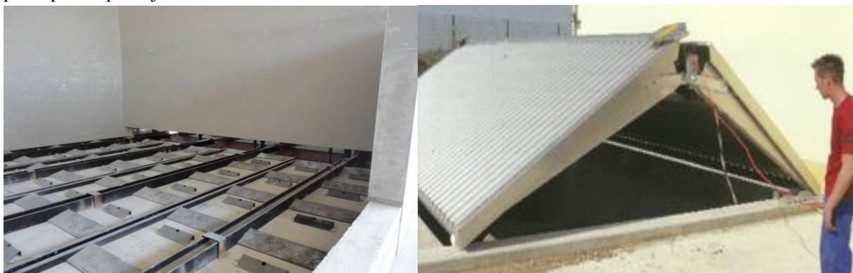
Limeni silos za pelete je primjereno je za ekonomično skladištenje jer zauzima malo prostora. Isporučuje se u različitim veličinama. Pomoću integriranih sustava za ulaz i povrat zraka omogućeno je, da se silosi punе direktno iz cisterni. U silose moguća je ugradnja prozorčića za kontrolu nivoa ili se ugrade senzori za automatsko javljanje zalihe.
