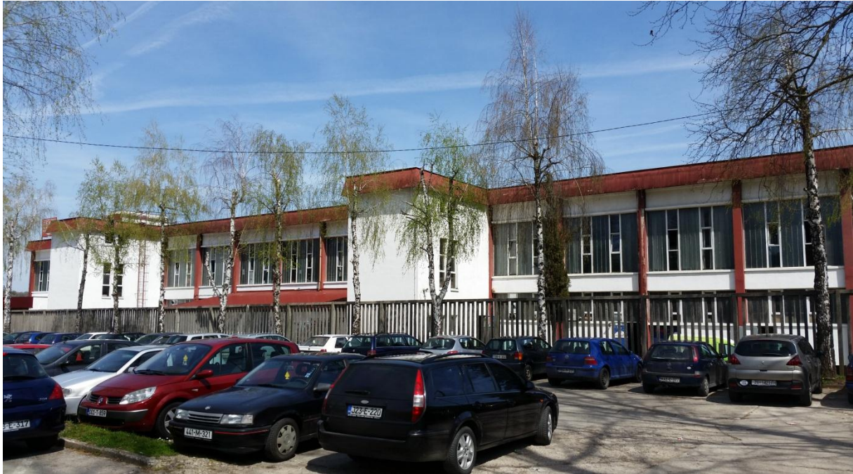
Slika 3.3. Jugozapadna strana objekta, pogled prema sjeveroistoku.
