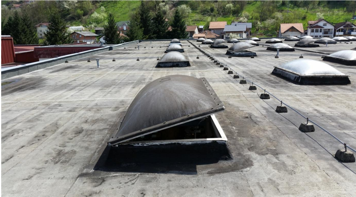
Slika 3.6. Ravni krov izoliran bitumenskom trakom i krovni prozori s kupolom od pleksiglasa
