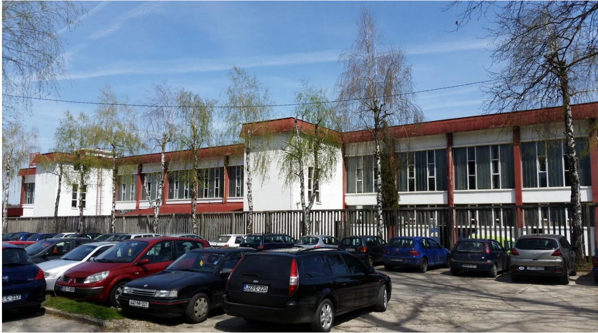
Slika 3.3. Jugozapadna strana objekta, pogled prema sjeveroistoku.
