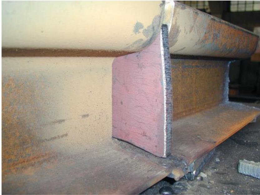
Slika 4.1. Postavljena specijalna umetna plo ica nakon zavarivanja nožice tra nice [20]
