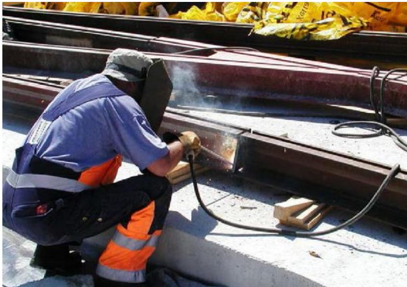
Slika 3.7. Zavarivanje žlebaste tračnice REL postupkom uz upotrebu čelične ploče [17]
