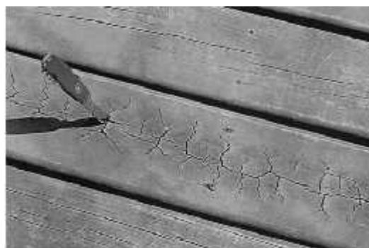
Slika 3. Pukotine na drvu nastale pod dugotrajnim utjecajem atmosferskih uvjeta [9].
