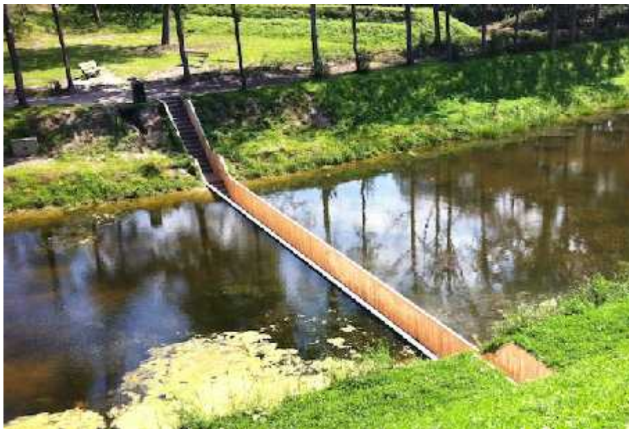
Slika 12. Mojsijev most izrađen od acetiliranog accoya drva u Nizozemskoj [31].
