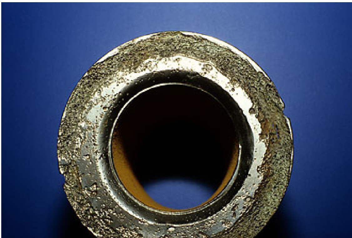
Slika 14. Posljedice korozije u procjepu na aseptičnoj prirubnici za farmaceutsku industriju [18]
